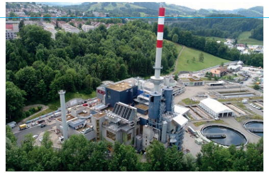
Entsorgung St.Gallen, Kehrlichtheizkraftwerk (KHK) St.Gallen
