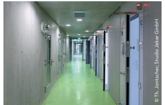
Planung und Fachbauleitung komplexer Türsysteme in Verbindung mit der Anlagentechnik
