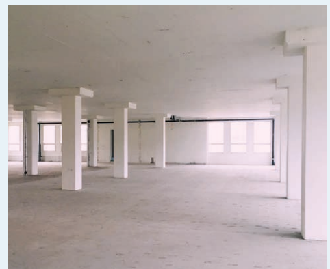
PL Bauherr in den SIA-Phasen 3-5 für den Rückbau/Sanierung des MABs im Ex Libris-Gebäude, Dietikon
