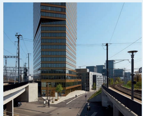
Bauherrenvertretung für den Mieterausbau von Amstein + Walthert AG im Andreasturm, Zürich
