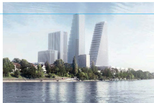
Roche Bau 2 und Projekt pRed, Basel
