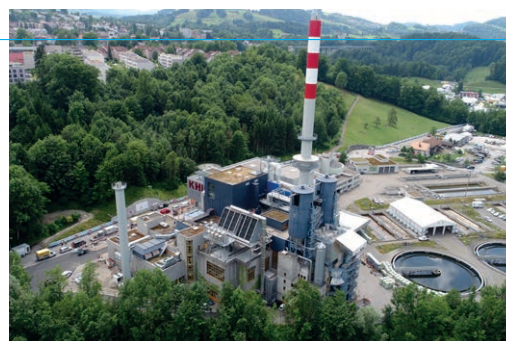
Entsorgung St.Gallen, Kehrlichtheizkraftwerk (KHK) St.Gallen
