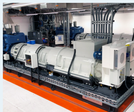
Installation d'alimentation dynamique sans coupure Diesel
