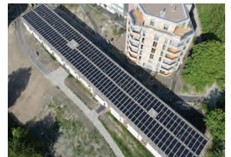
3 Die 114 kW starke PV-Dachanlage erzeugt 125'000 kWh/a.
