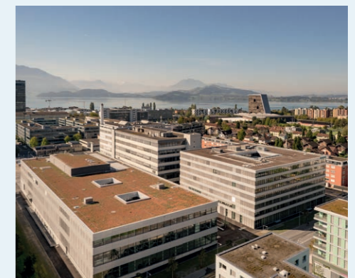
pbFM und Nutzervertretung für den Neu- und Umbau des Büro- und Produktionsgebäudes von Siemens, Zug mit Besucherzentrum und Labor
