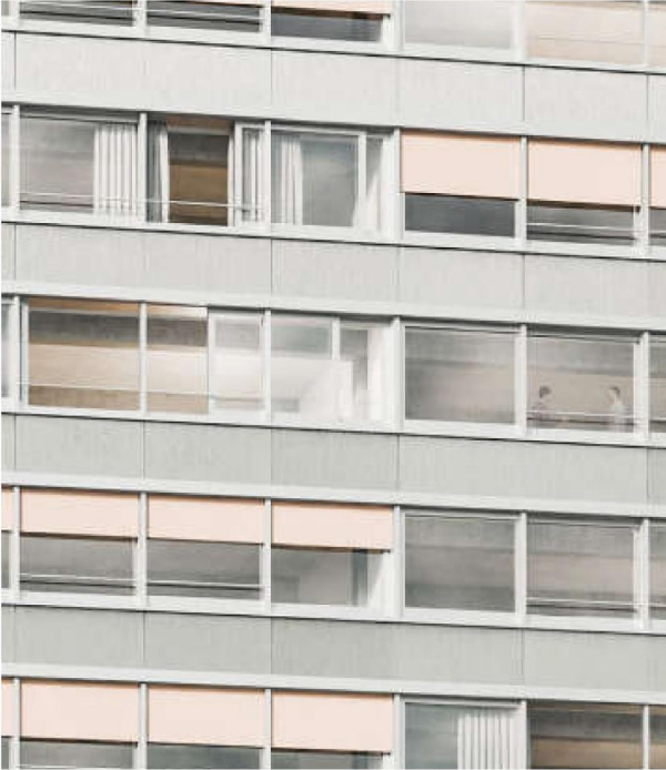
Längsfassade mit Fensterband und PV-Modulen im Brüstungsbereich
